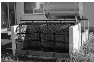
破損したゴミステーション（美山団地）
