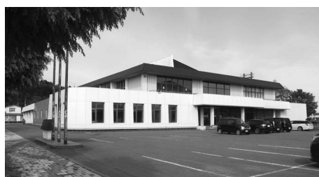
耐震化工事を行う体育館
