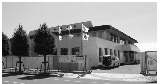
耐震化改修工事中の総合体育館
