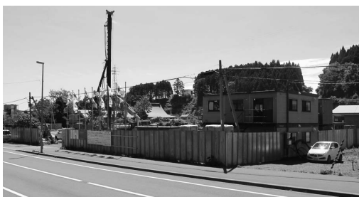
建設工事中の吉岡総合センター
