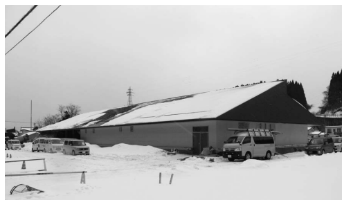
完成に向け工事が進む吉岡総合センター
