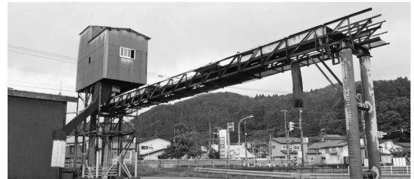
現在の碎氷施設（吉岡漁港内）
