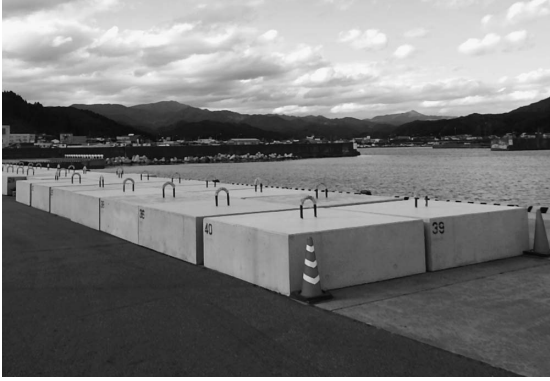
福島漁港内に仮置きされた養殖ブロック
