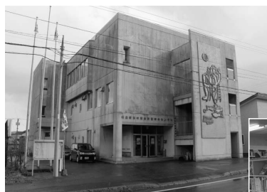
←老朽化が進む吉岡漁村環境改善センター（吉岡支所）
