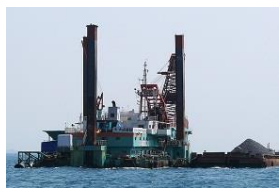
ボスフォラス海峡で工事をしている大成建設の様子
